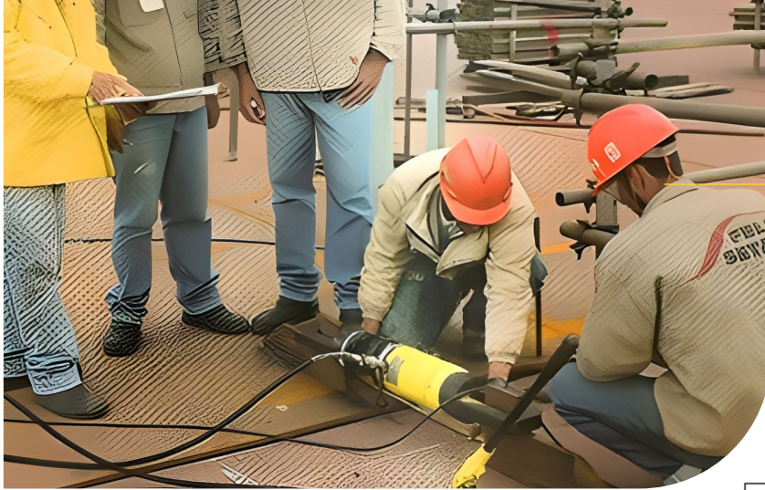
* Canteiro de obras para construção da P-52
