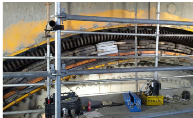
■ TBEM-1500 - usada para manutenção em estator de moinho de bolas SAG.
