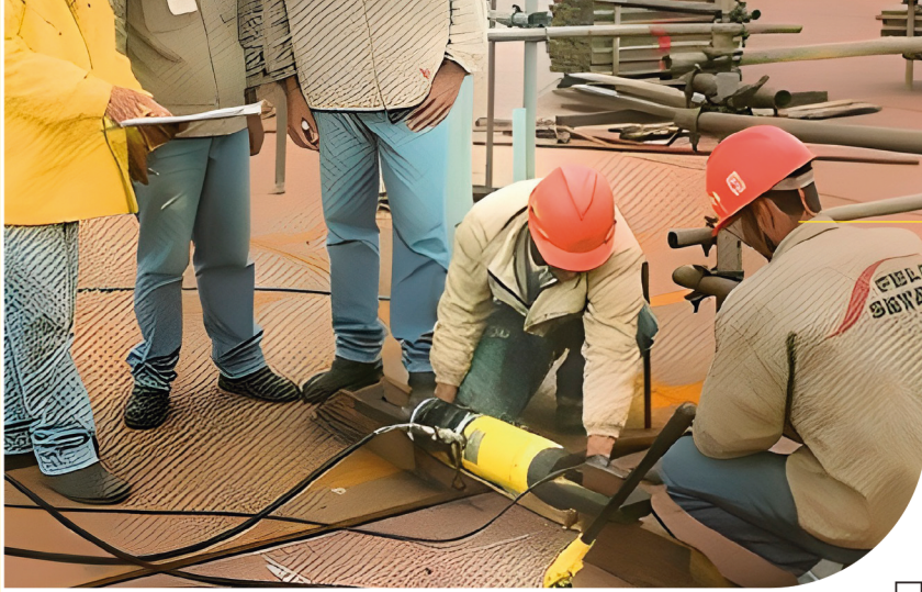
* Canteiro de obras para construção da P-52
